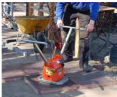
Over het zandbed gaat vervolgens de bestrating.
