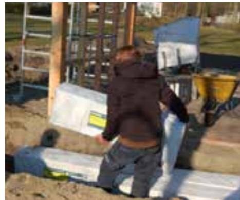
Plaats de Hydroblob® infiltratieblokken rechtopstaand, zo kunnen ze een hogere druk opvangen en infiltreren ze het snelst regenwater.
