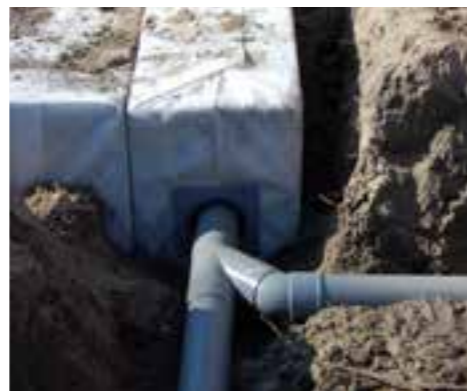
Sluit de regenpijp van hemelwaterafvoer en lijnafwateringsgoot aan op de geperforeerde buis van het infiltratieblok BD112.
