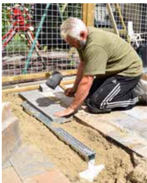
Vul de ruimte tussen infiltratieblok D45 op met ophoogzand. Houd hierbij rekening met de dikte van uw bestrating.
