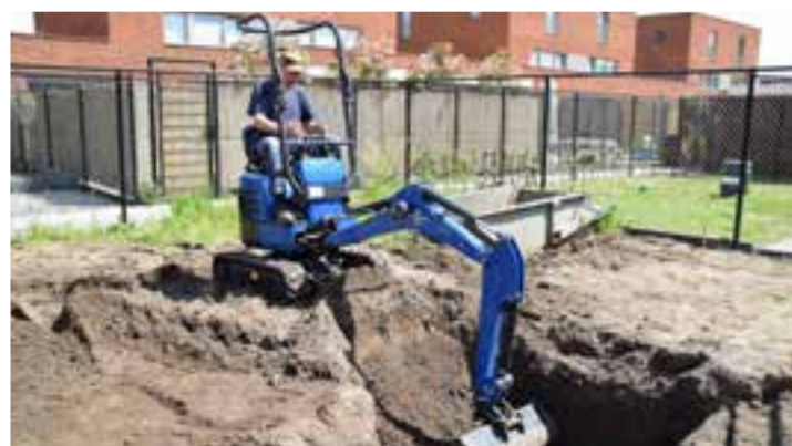
Inmiddels wordt een gat uitgegraven. Hier was de grondlaag hard en is er uitgegraven tot op een zachte zandlaag. Deze zandlaag neemt namelijk sneller water op.
