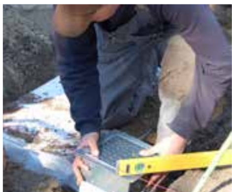
Stel de infiltratieput IP15 zo dat de bovenkant van de put circa 3 mm lager ligt dan de bovenkant van de bestrating, en zorg dat de infiltratieput contact maakt met een infiltratieblok.
