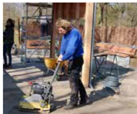
Hierna trilt u het zandbed waar de bestrating op komt te liggen weer stevig aan.
