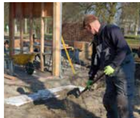
Na plaatsing en aansluiting van de Hydroblob® blokken, brengt u weer een zandlaag van minimaal 10 cm over de blokken aan.
