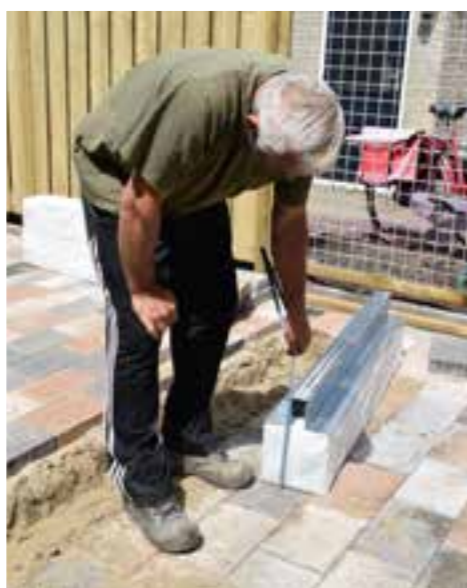
Meet goed de hoogte uit waarop de diepte van plaatsing wordt bepaald.
