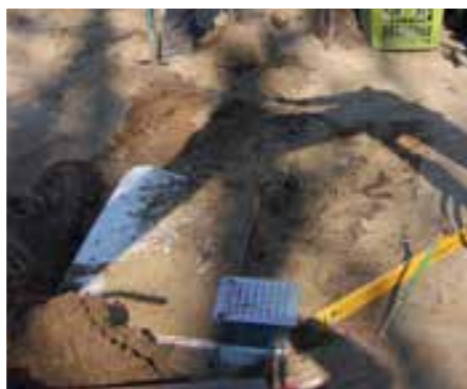
Vervolgens graaft u de 2 infiltratieblokken weer in met minimaal 15 cm straatzand. Het infiltratieputje steekt in dit geval boven het zandbed uit.
