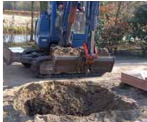
Gat uitgraven ten behoeve van 1 stuks Hydroblob® type BD112 en 3 stuks Hydroblob® type D112 infiltratieblokken.
