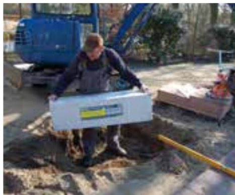
Plaats de Hydroblob® infiltratieblokken rechtopstaand. Zo kunnen ze een hogere druk aan en infiltreren ze het best.
