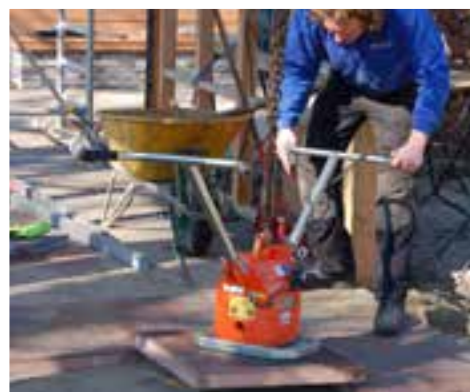
Op de zandlaag plaatst u vervolgens uw bestrating.
