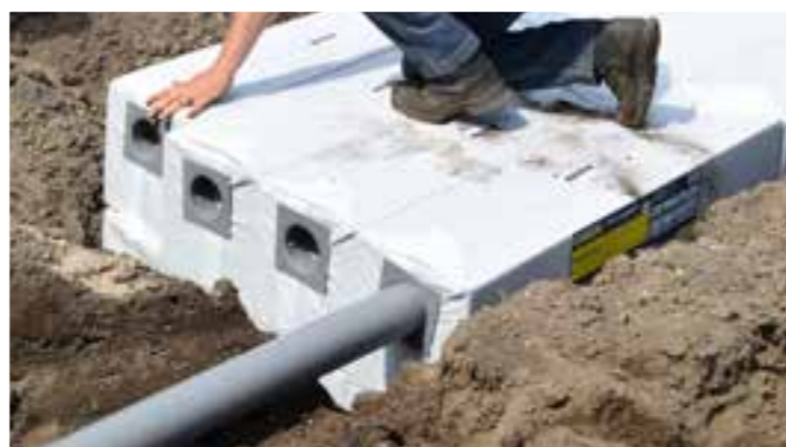
De 16 Hydroblob blokken worden geplaatst. Op de vier blokken met geperforeerde buis type BD worden regenpijp, veranda en lijnafwateringsgoten aangesloten.
