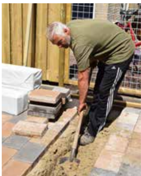
Graaf een gat waarin u de D45 infiltratieblokken plaatst.
