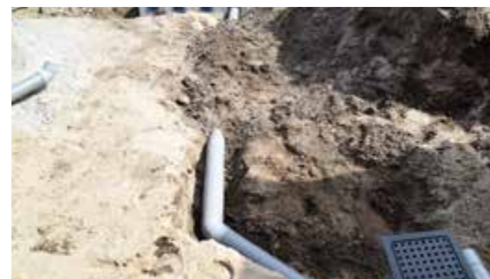
Vanaf de Zandvangput wordt een PVC pijp gelegd en aangesloten op het eerste BD blok. Vervolgens gebeurt dit op dezelfde manier met veranda en lijnafwateringsgoten.
