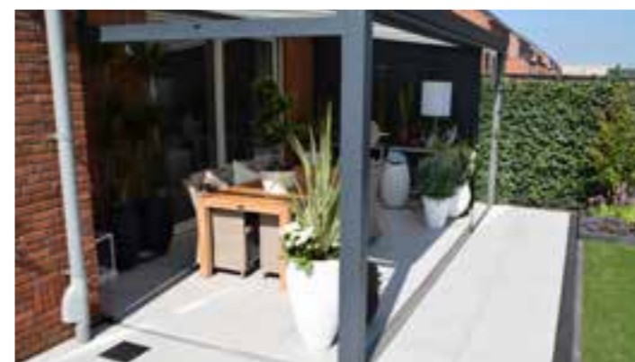
Op deze foto ziet u drie aansluitingen die zijn aangesloten op de Hydroblob BD112 blokken. De regenpijp van het huis, de regenpijp van veranda die weggewerkt is in de staander en de lijnafwateringsgoot langs de bestrating.
