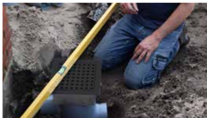
Hierna wordt de zandvangput waterpas gesteld op het niveau van de bestrating.
