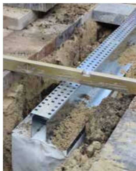
Laat van twee kanten uw bestrating op afschot van minimaal 1 cm per strekkende meter naar de infiltratieblokken lopen.
