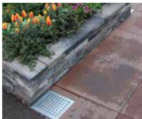
Zo ziet het resultaat er uiteindelijk uit. Alleen het mooie rooster van de infiltratieput IP15 blijft zichtbaar. Totale buffer capaciteit in dit geval is 240 liter.
