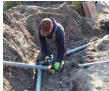
Laat de regenpijp op afschot naar de infiltratieblokken lopen en verlijm ze goed met PVC lijm.
