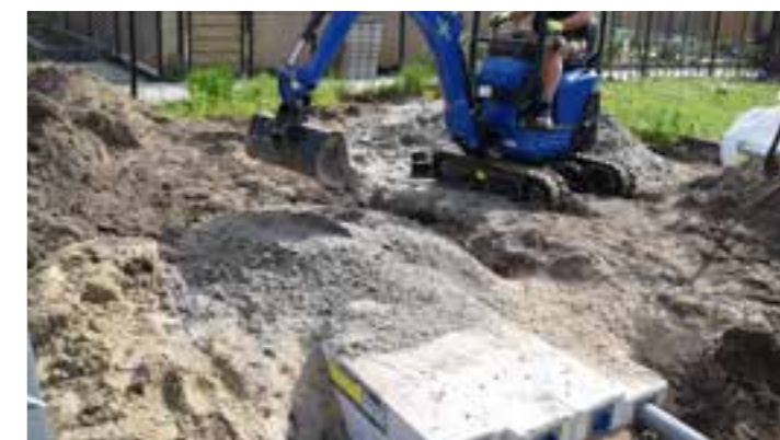
Als alles is aangesloten worden de blokken ingegraven met een zandlaag, en in dit geval bedekt met een kunstgrasmat.
