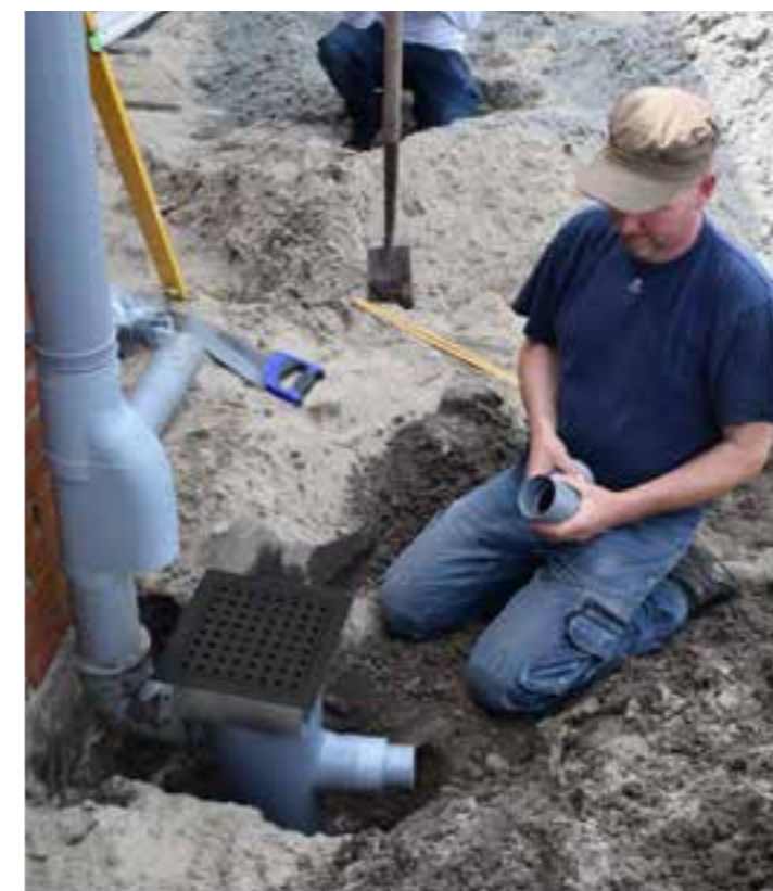
Laat van twee kanten uw bestrating op afschot van minimaal 1 cm per strekkende meter naar de infiltratieblokken lopen.
