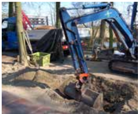
Graaf een gat dat groot genoeg is voor de infiltratieblokken. Zorg er voor dat er over de blokken nog minimaal 15 cm straatzand verwerkt kan worden.
